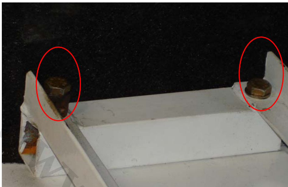
استفاده از دو مهره هرز برای جبران بلندی پیچ در مقایسه با سایر اتصالات پایه مخزن
